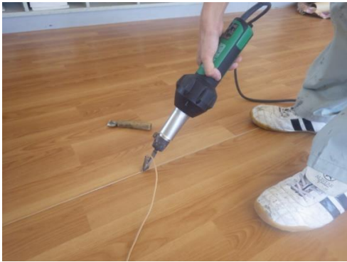
ビニル床シートの継目は、溶着棒で溶着
